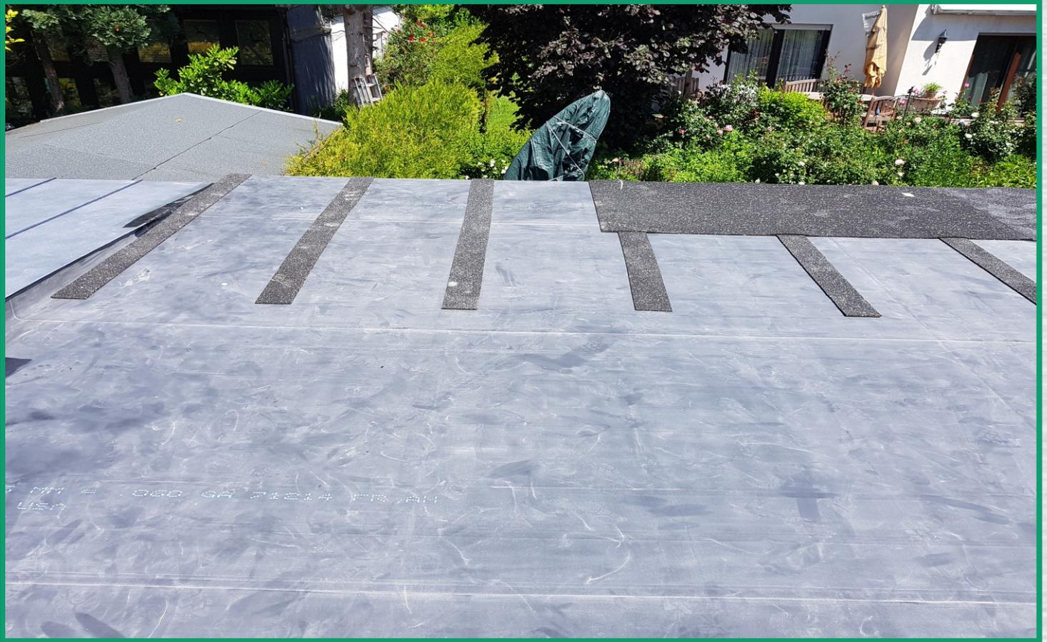
Flachdachsanierung mit Gefälle - EPS
