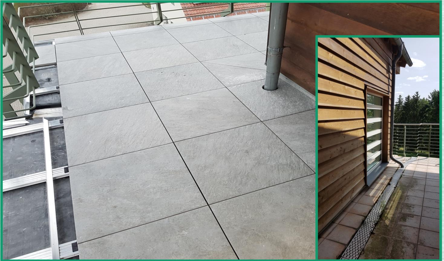
Die Dachentwässerung konnte unter das Feinsteinzeug verlegt werden in Kombination der Systeme 80 und 160 von der Balko-Drain GmbH. Die spezielle Ablaufrinne wurde mit dem System 160 gefertigt.
