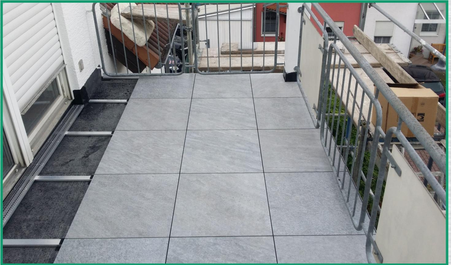
Hier sieht man noch den Unterbau - Abdichtung, Gitterrost, BD-System 80
