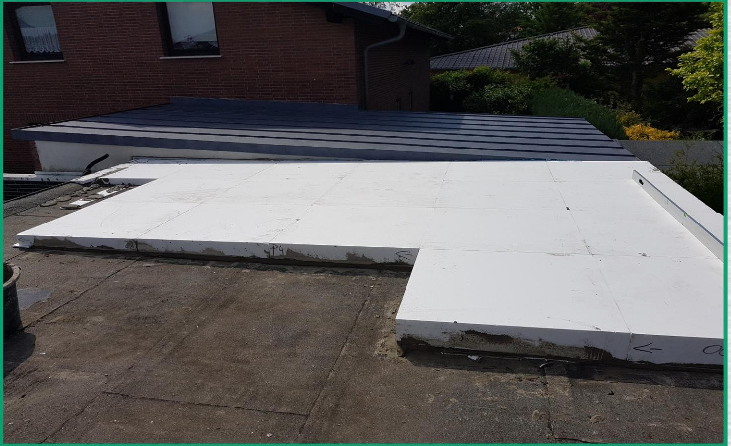
Flachdachsanierung mit Gefälle - EPS
