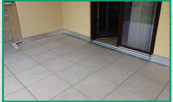
Fertige Verlegung der Fliesen, Gitterrost im Bereich der Türen, L&S Abschlußschiene an der Wand
